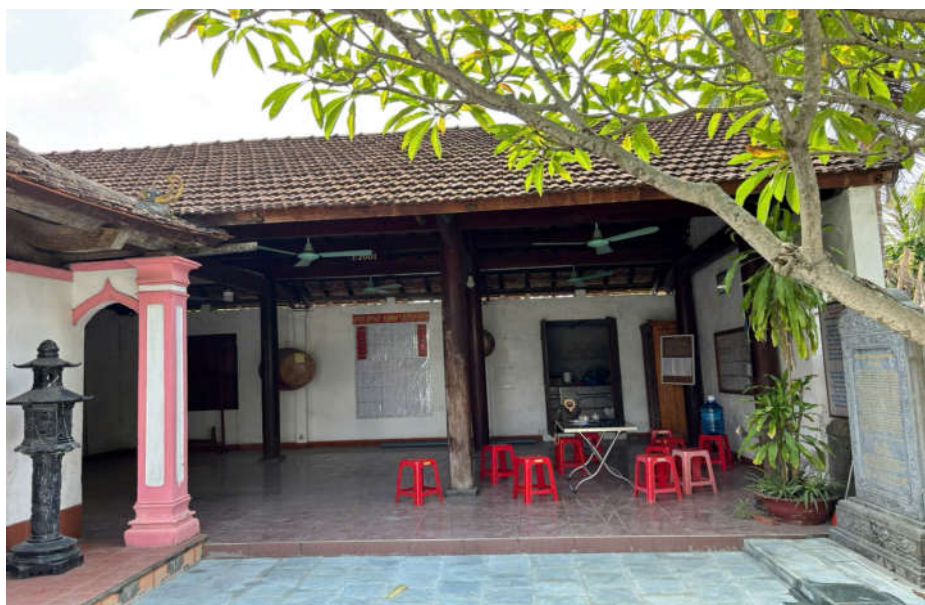
Nhà hạ đường được xây dựng năm 2001
